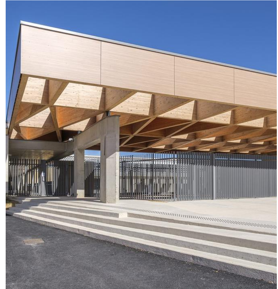
Colegio Voltaire, Nimes, Francia Construido con concreto Vertua, parte de nuestra familia de productos sostenibles Vertua
